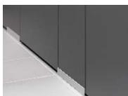
Fixation au sol par un profilé en U aluminium.
