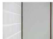
Raccordement frontal et mural avec profilés en U aluminium, 17 x 30mm.
